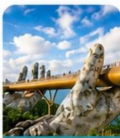
สะพานมือสีทอง
